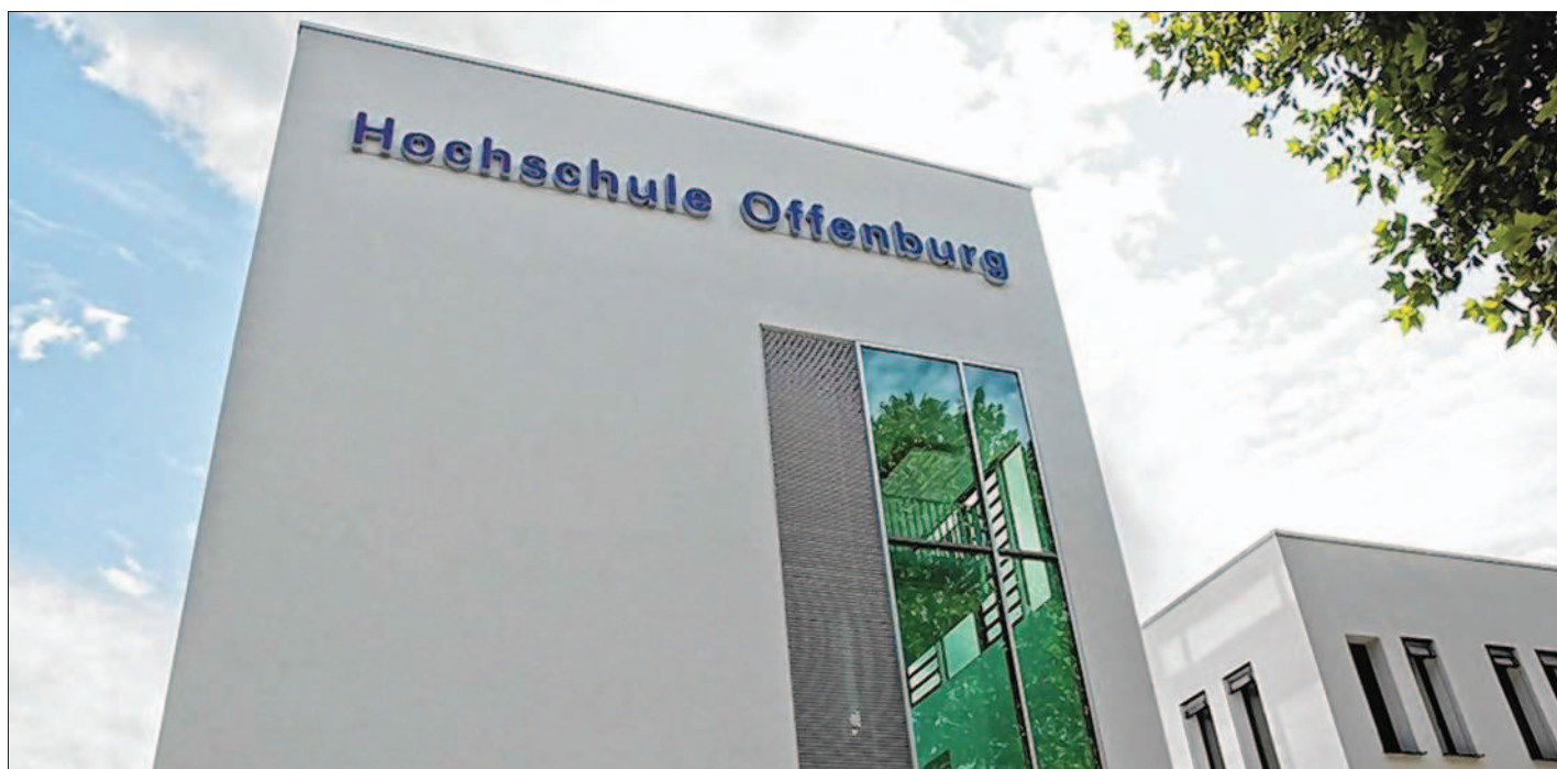
An der Hochschule Offenburg beschäftigen sich die Mitarbeiter mit den Studenten unter anderem mit Klimaforschung, Batterietechnik, Simulationen von Raumströmungen und Heizungssystemen. Foto: Hochschule Offenburg
