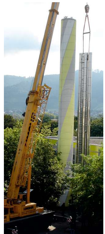
Abb. IV.18-1: Am 22.08.06 an der Hochschule Offenburg montierter 18 m hoher Kamin
