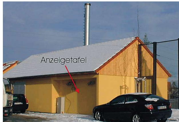
Abb. IV.7-3: Heizzentrale der Nahwärmeversorgung Baugebiet Hülben, Holzgerlingen
