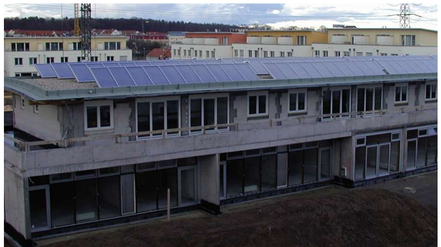
Abb. IV.7-4: Gesamtes Kollektorfeld (251 m 2 ) auf dem Flachdach des Kindergartens in Holzgerlingen
