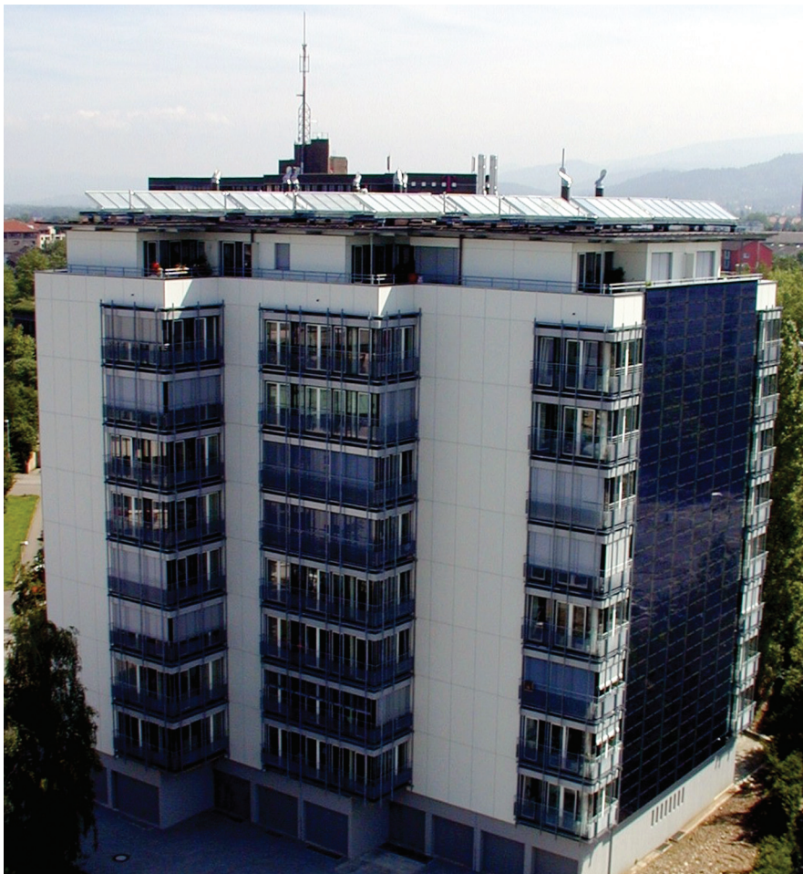
Abb. V.13-2: Beispiel einer von der Fachhochschule Offenburg betreuten thermischen Solaranlage mit Fotovoltaik im Wohngebäude Wilmersdorfer Straße in Freiburg. Die Sonnenkollektoren sind auf dem Flachdach aufgeständert.
