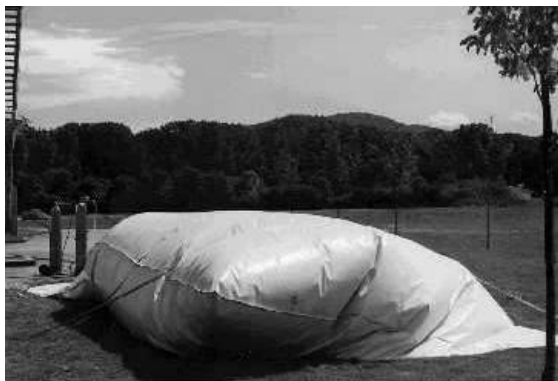
Abb. III.18-2: Der 60 m 3 Gasspeicher wird zur Aufnahme der Motorkennlinien mit Synthesegas gefüllt.
