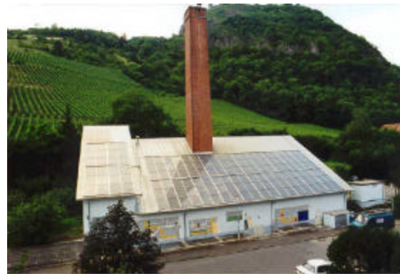
Abb. III.13-1: Kollektorfeld der Solaranlage Kreis-krankenhaus Singen in Solar-Roof-Ausführung.
