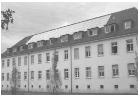
Abb. III.13-4: Kollektordach im Studentendorf Vauban in Freiburg
