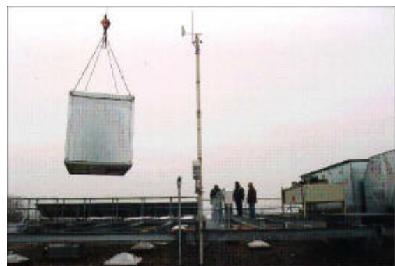
Abb. III.11-1: Montage der Energieinselsystemkomponenten auf dem Labordach.
