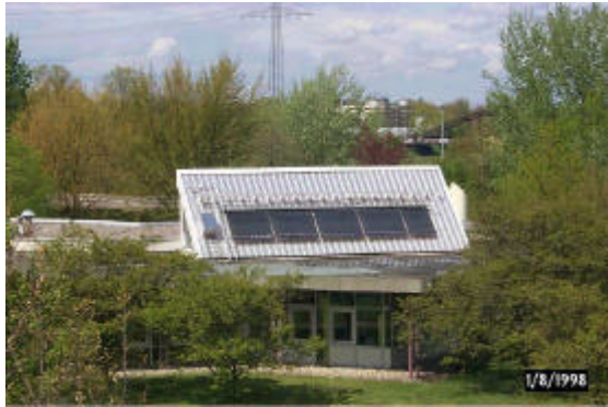
Abb. III.12-2: Ansicht des Kollektorfeldes der Mensa-Solaranlage
