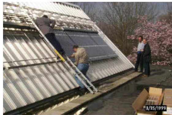
Abb. III.12-1: Montage der Kollektoren auf dem Mensadach
